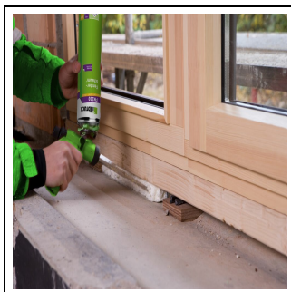
2.Bild: Verarbeitung der Fensteranschlussfuge mit FM220.
